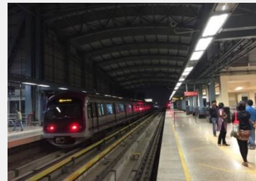
※バンガロールの公共インフラ整備の様子
